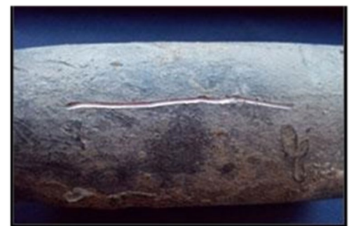
Imagen de una raya en una línea de servicio de plomo
