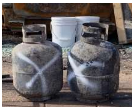
环保局检查后会将一些空的容器上标上白色X号留到第二阶段再移除。
