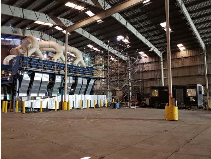
Unidades Torit Baghouse Descontaminación y Deconstrucción
