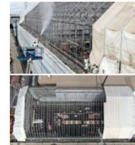
Eliminando la Unidad de Recinto Completo de Segmento 2 del Edificio de Fundición.
