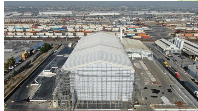
Desmantelamiento del FEU
