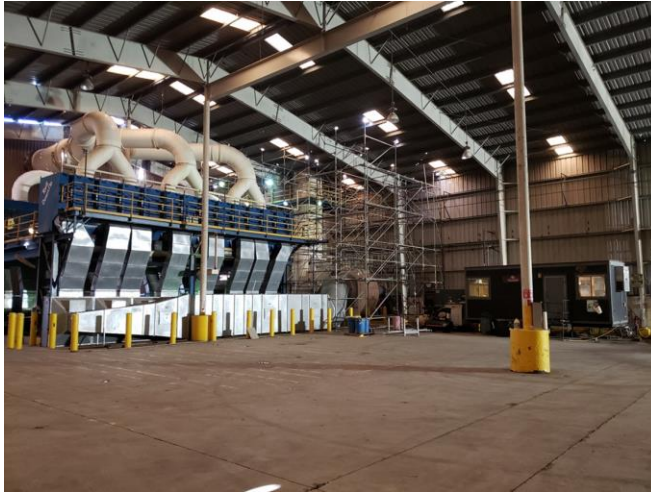
Unidades Torit Baghouse Descontaminación y Deconstrucción
