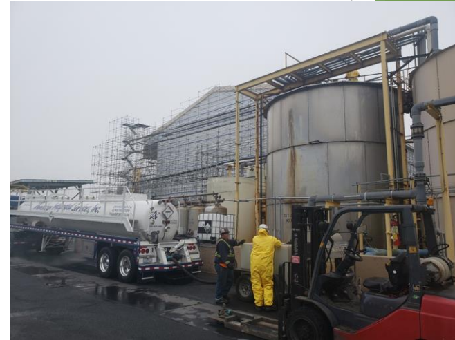
Limpieza de tanques de la Planta de Tratamiento de
